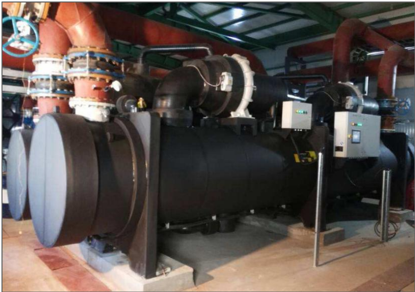
串联逆流双系统离心式高温热泵
